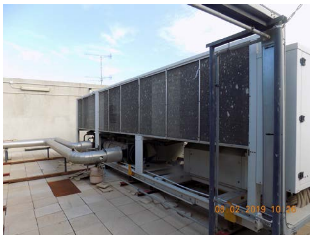
Gruppo Frigo CORPO "E" privo di un compressore
