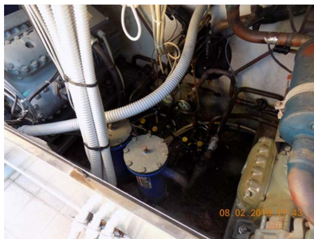
Gruppo Frigo CORPO "D" con evidenti perdite di olio
